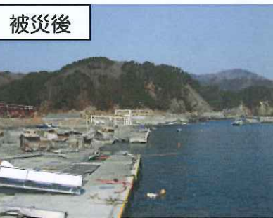
岸壁の復旧状況（岩手県音部漁港）
