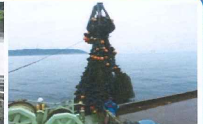
(専門業者による撤去作業)
