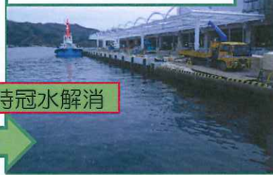
施工後（岸壁高上げ）
