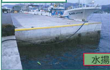
岸壁高上げ後
