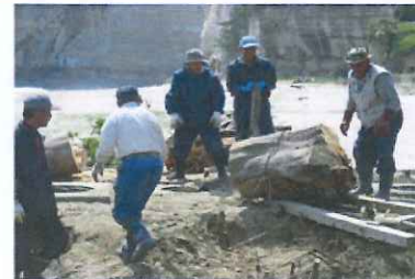
(漁業者による撤去作業)
